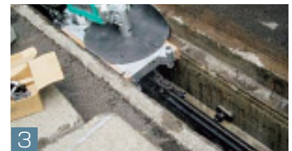
3 W 2 Rカッターによる側壁の水平切断
