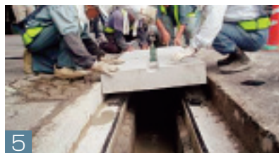
5 W 2 R蓋版の設置
