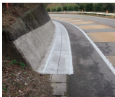
国道266号単県側溝整備
