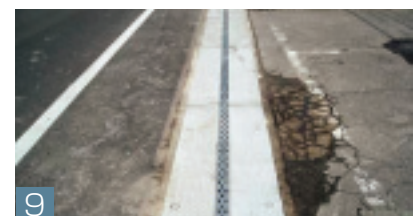
9 修繕後（W 2 R蓋設置）の状況
