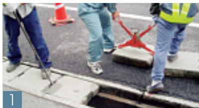
1 既設蓋版撤去
