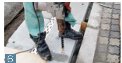
6 アンカー筋取り付け用穴の削孔
