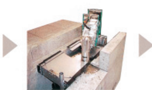
W 2 Rカッターによる切断
