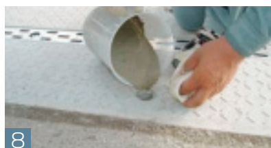
8 アンカー筋固定用モルタル充填
