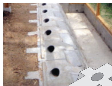
施工イメージ
