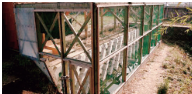
屋外における動物生態観察施設外観
