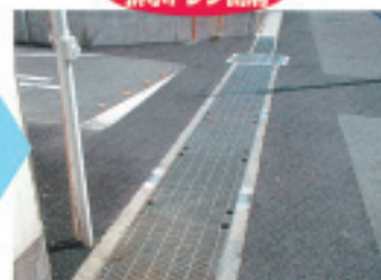
排水ドレン側溝
