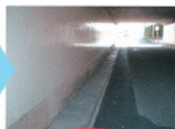
排水ドレン側溝
