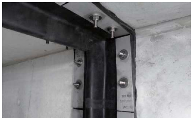
仕上がり状況
