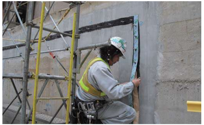
シール材貼付け状況
