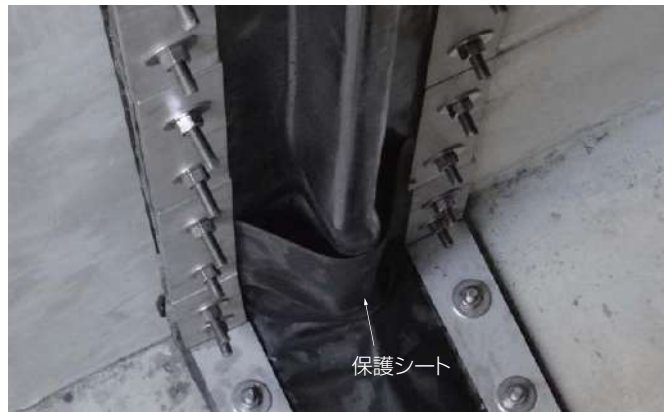
保護シート取付状況
