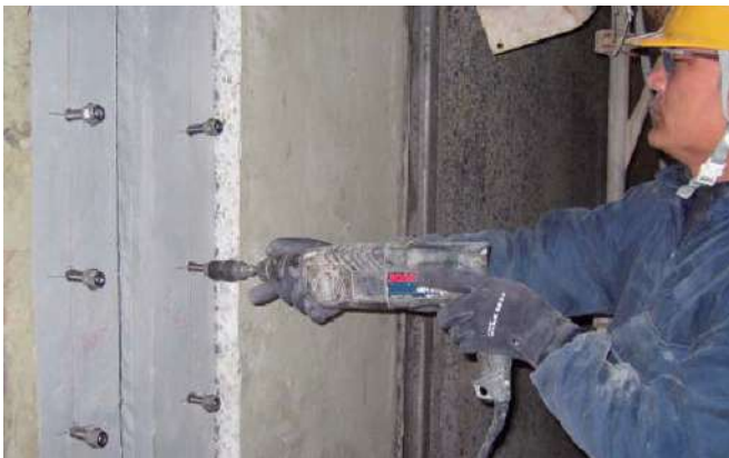
アンカー打ち込み状況
