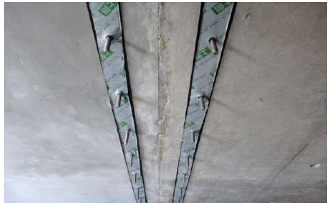
シール材貼付け状況
