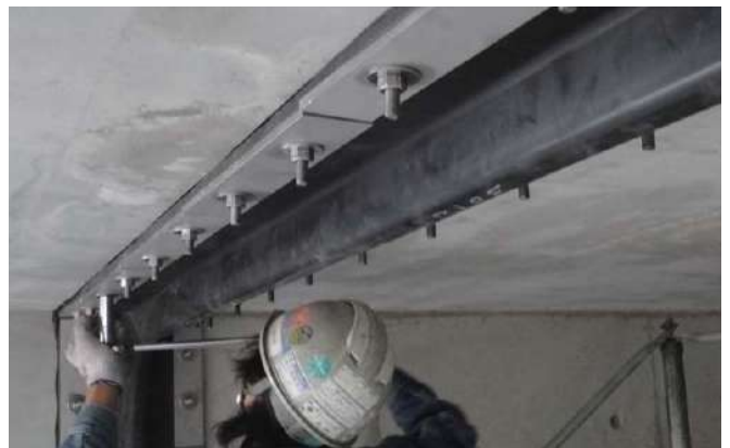
押さえ板取付状況
