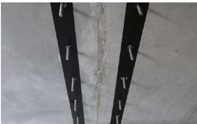
サンタックボンドPB-50塗布状況
