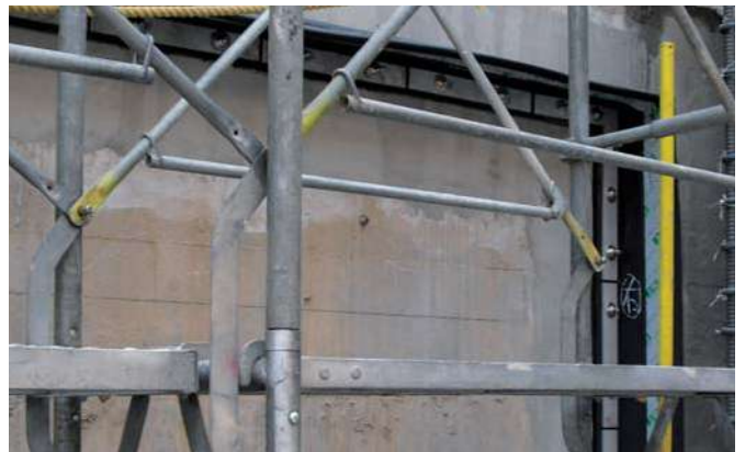
仕上がり状況
