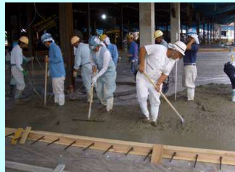
コンクリート打設
