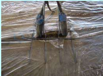
補強筋設置
