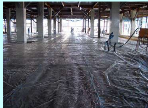
コンクリート打設前
