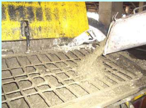
ミキサー車からポンプ車へ排出
