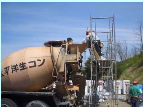
シムロックを投入し生コンと攪拌
