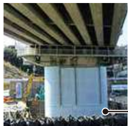
耐震補強・コンクリート巻き立て工
