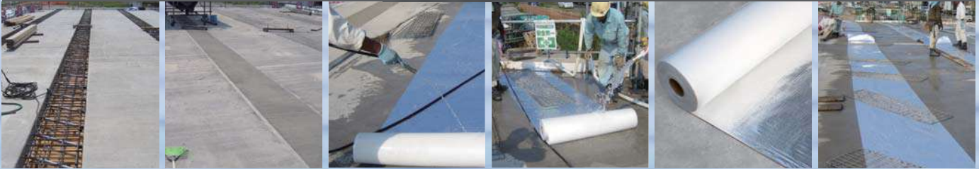
コンクリート打設前
