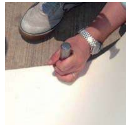
ポンチにて穴開け加工
