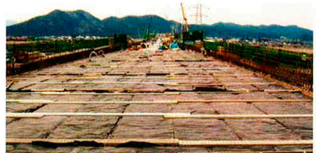
Q マット使用例(高架橋スラブ)
